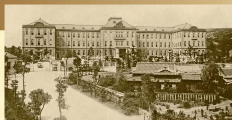
八幡製鉄所事務所=1929年、八幡市(現・八幡東区)
